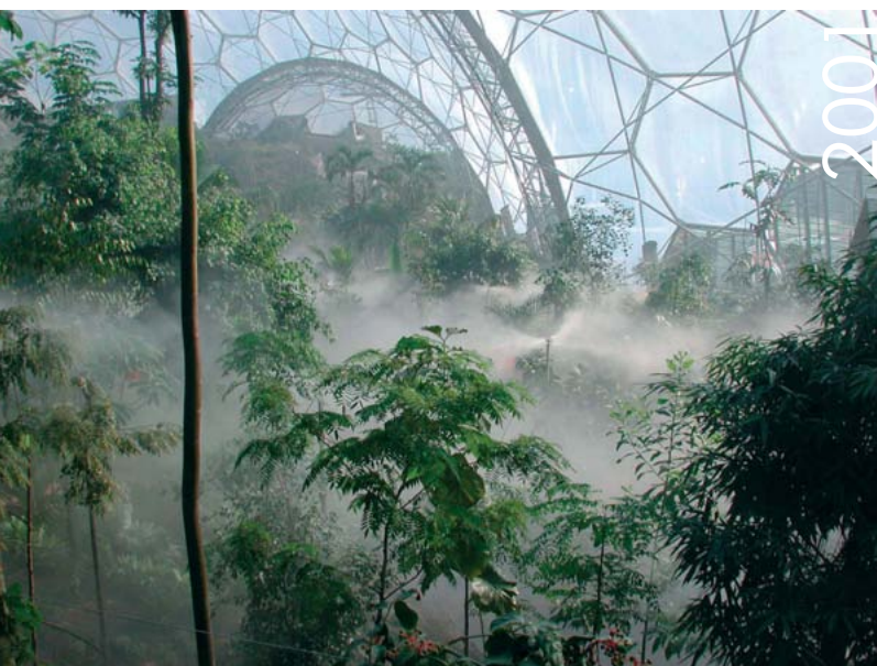
Eden Project. Le serre botaniche in Cornovaglia caratterizzate da cupole di tre strati di fibra ETFE.
