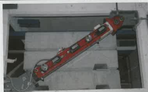
EDIFICIO PROTETTO CON DISSIPATORI
