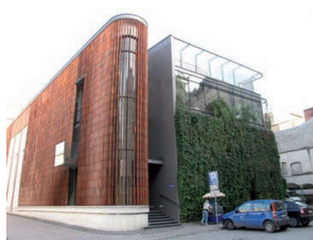
Krakow City Information And Exhibition Center Ingarden & Ewy Architekci. wEsempio di elementi di seconda pelle differenti, applicati in maniera mirata a diverse porzioni di involucro
