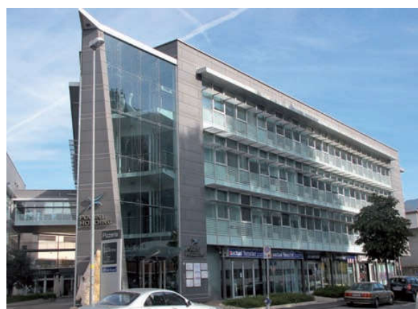
Podini Holding, Bolzano. HANASK, Milano. Il progetto di architettura è centrale rispetto ai temi legati all'efficienza energetica
