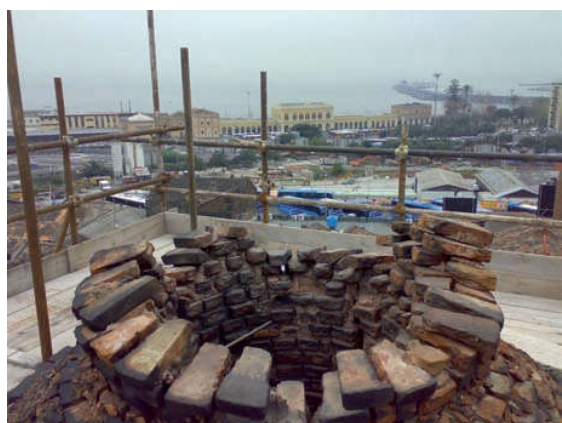
Il coronamento della ciminiera durante le fasi di smontaggio e rimontaggio dei mattoni laterizi.
