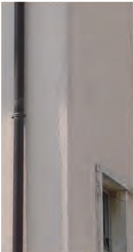
2. Fessurazioni in prossimità degli spigoli degli elementi strutturali verticali che denotano la corrosione delle armature longitudinali. 3. Controsoffitto di tipo "Perret" (immagine ripresa durante l'esecuzione dei lavori).
