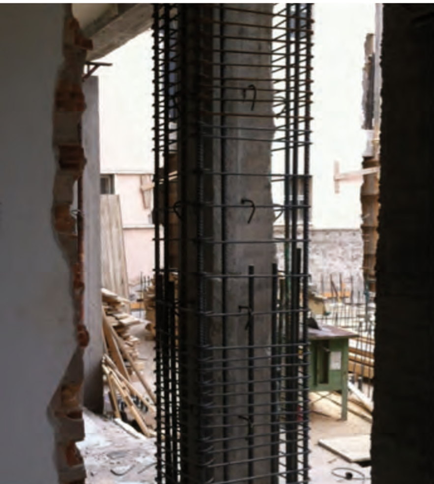
4. Inserimento di nuove barre longitudinali e trasversali.
