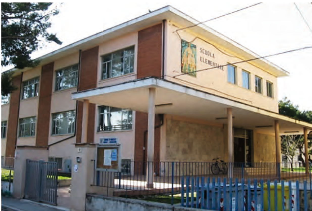
Porticato d'ingresso prima dell'intervento
