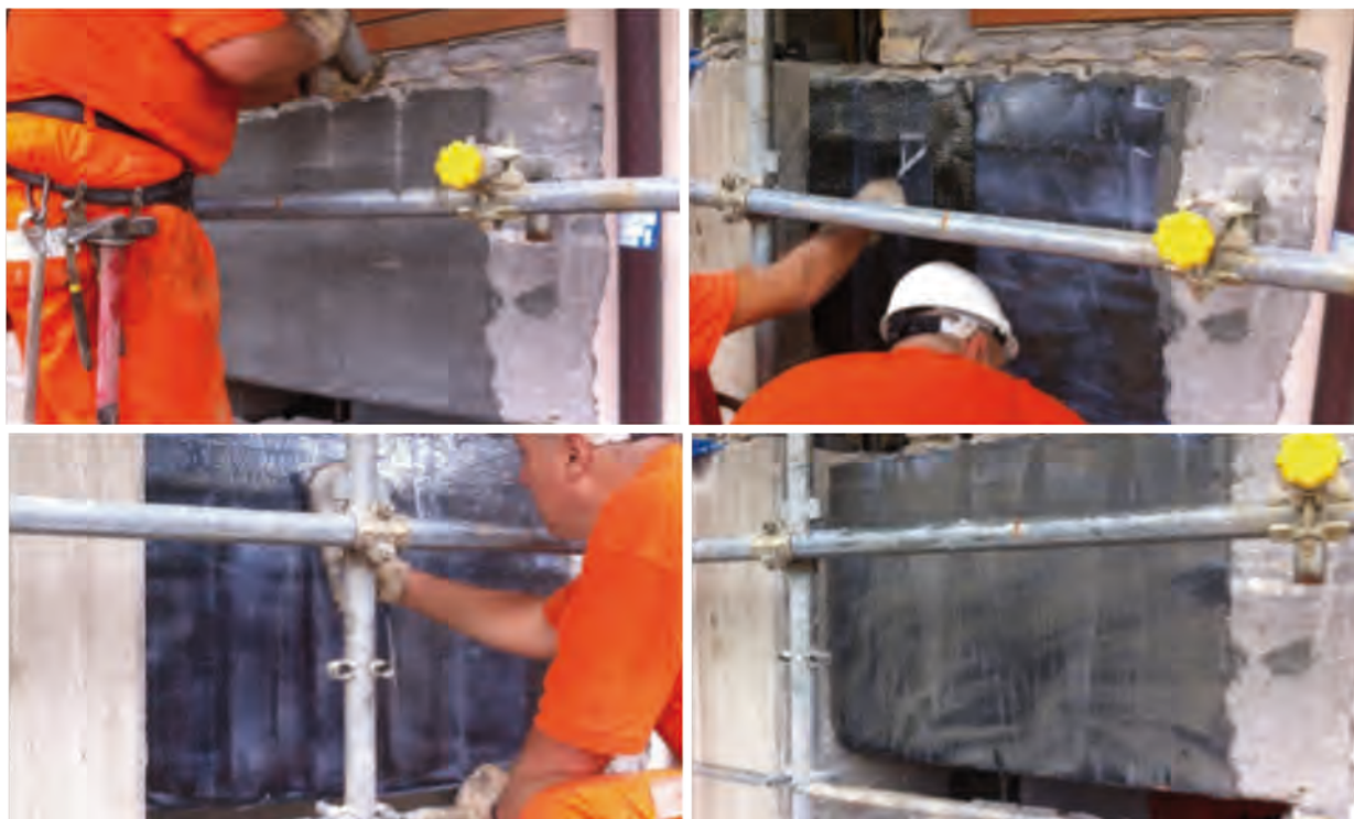
5. Rinforzo a taglio delle travi tramite fasciatura a completo avvolgimento in FRP in fibra di carbonio
