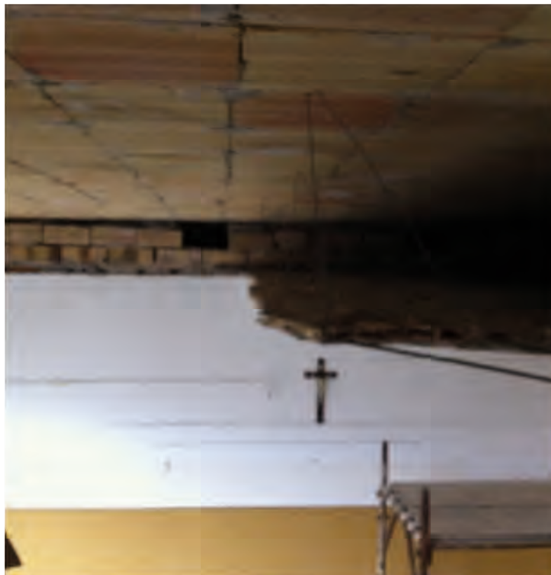
2. Fessurazioni in prossimità degli spigoli degli elementi strutturali verticali che denotano la corrosione delle armature longitudinali. 3. Controsoffitto di tipo "Perret" (immagine ripresa durante l'esecuzione dei lavori).
