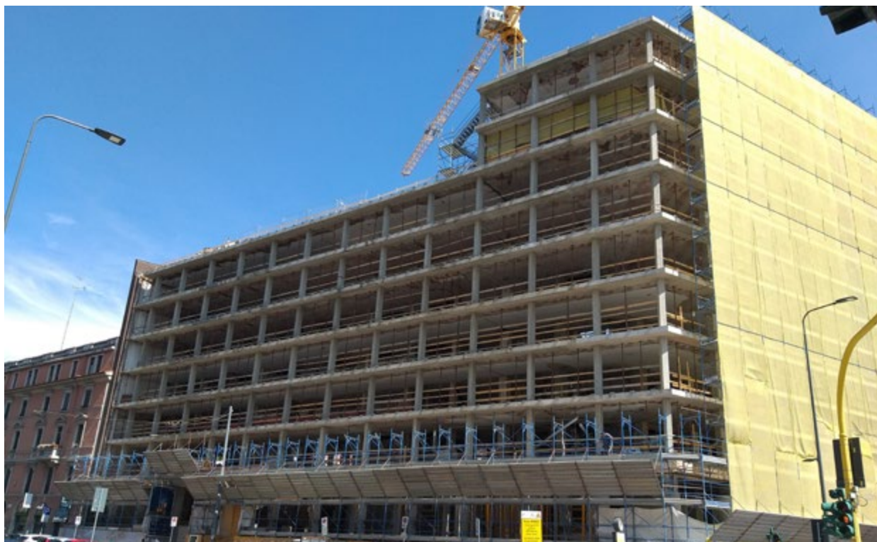
In facciata, nuovi pilastri e travi in spessore, strutture esili, che si nascondono dietro alla scansione dei montanti verticali e orizzontali delle cellule di facciata, concorrendo a perseguire gli intenti di trasparenza, luminosità e permeabilità del progetto.
