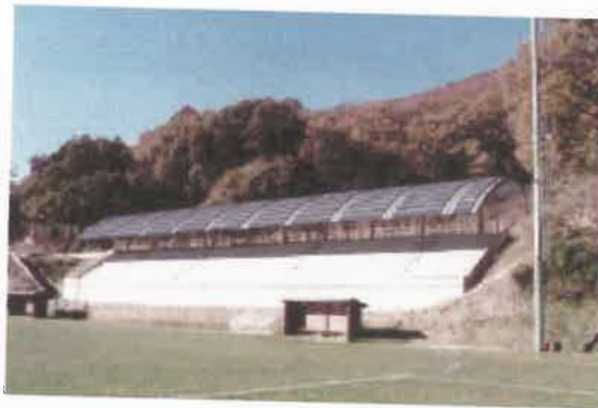
Comune di Trevigiano: copertura del Campo Sportivo.
