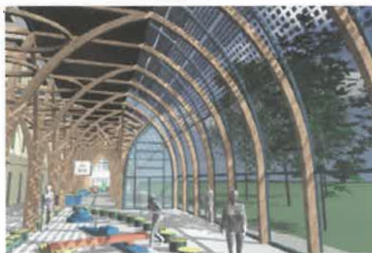
Comune di Firenze: facciata-Copertura dell'Ospedale Pediatrico Meyer La serra bioclimatica che integra il FV come sistema di ombreggiamento sulla superficie vetrata. L'apporto termico dovuto al surriscaldamento delle celle contribuisce in inverno al riscaldamento e innesca d'estate moti convettivi che migliorano la ventilazione naturale, favorendo il raffrescamento. Potenza impianto: 30,13 kWp
