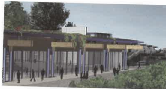
Comune di Imperia: copertura del Palazzetto dello Sport.
