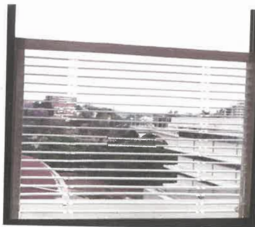
Esempio applicativo dei Laser Cut Panels. Questo sistema devia la luce entrante verso l'alto può causare abbagliamento: preferibile installarli sopra al livello degli occhi.
