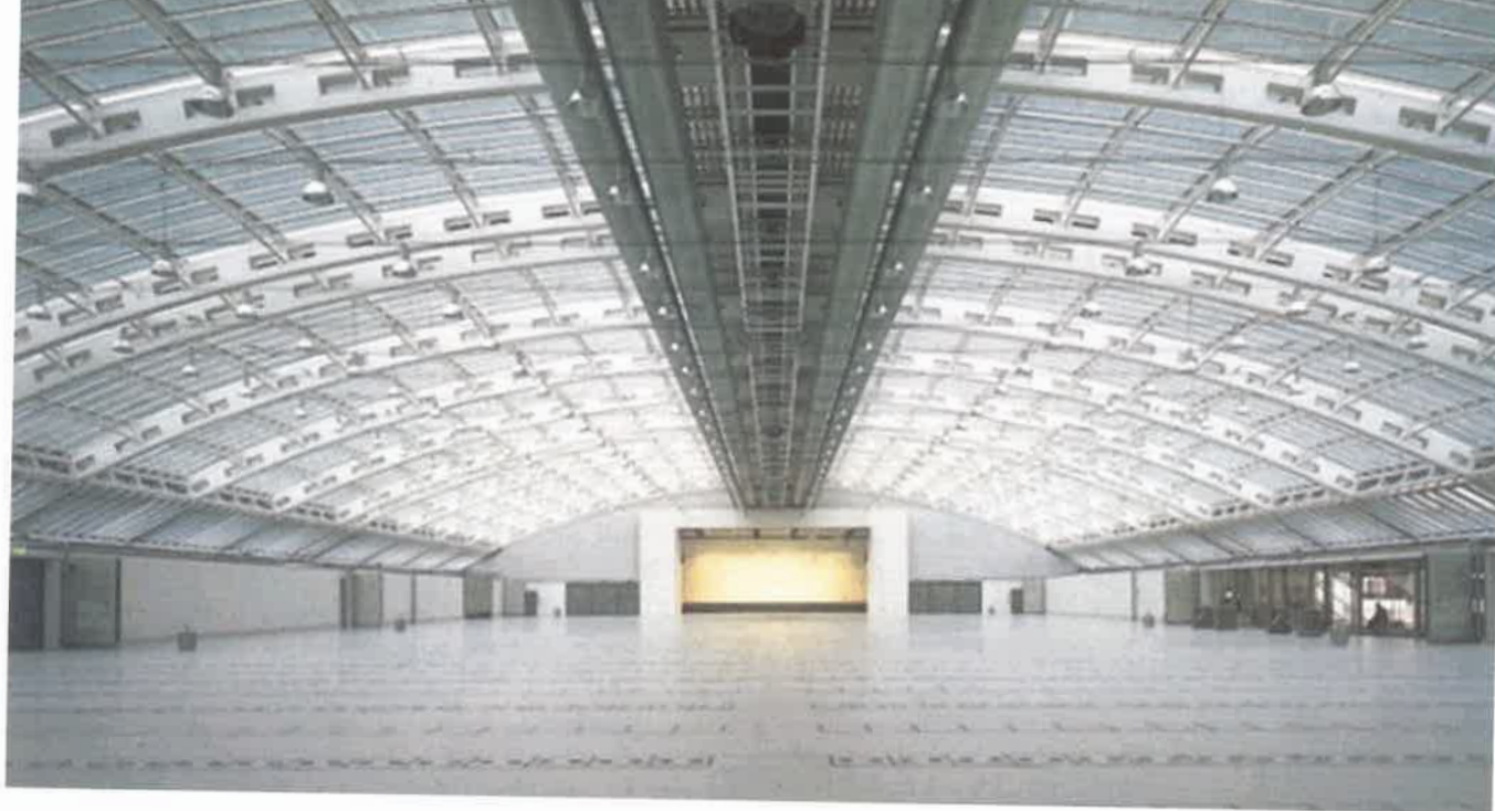
Thomas Herzog, Centro Per Mostre E Convegni, Linz. Un esempio di applicazione dei Prismatic Panels. Esempio di Prismatic Panels: vengono ubicati in facciata verticale, su lucernari o su tetti vetrati e sono ideali per tutti i tipi di clima.
