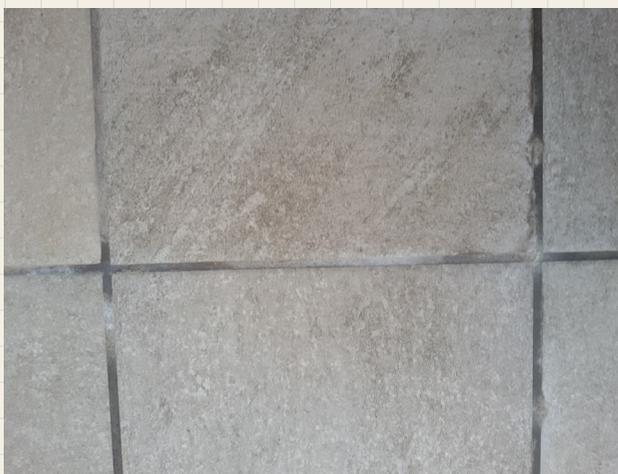
Nelle immagini sono visibili, quale semplice esempio, incrostazioni e concrezioni calcaree di una tubazione di scarico e concrezioni calcaree su una pavimentazione di un balcone. Un'incrostazione è un deposito stratiforme compatto e generalmente aderente al supporto. Si definisce concrezione quando, invece, il deposito è sviluppato preferenzialmente in una sola direzione non coincidente con la superficie del supporto e assume forma stalattitica o stalagmitica.
