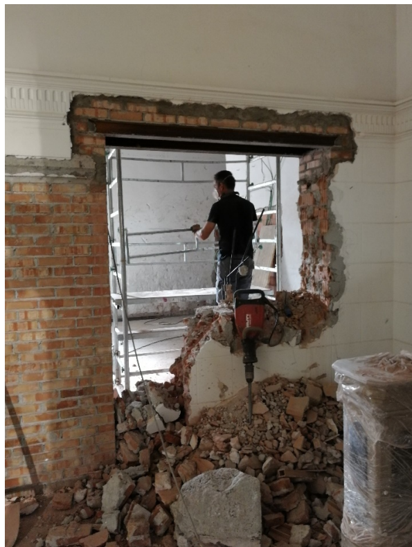
Intervento di cucì/scuci su muratura al fine di allineare le aperture in verticale
