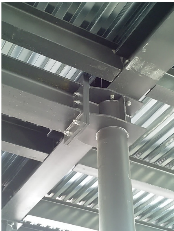
Nodo di sommità del telaio metallico della nuova copertura incastrato nelle due direzioni
