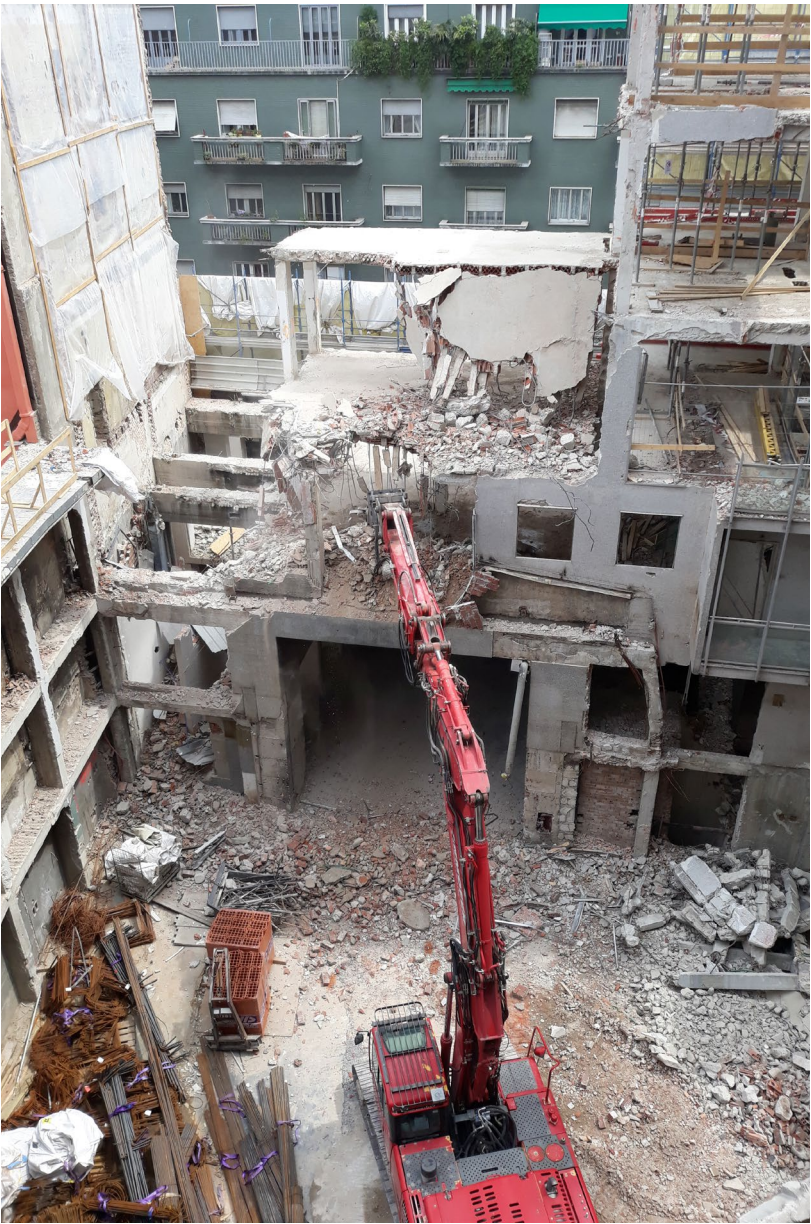
L'involucro esterno dell'edificio mantiene la sua attuale configurazione, mentre la corte interna viene interamente demolita e ricostruita per realizzare una spettacolare lobby d'ingresso vetrata a tutta altezza, che permette agli utenti esterni di cogliere l'opportunità di accesso o di visione della nuova corte centrale, ampio spazio comune, luogo di incontro e di lavoro, fulcro delle attività dell'edificio.
