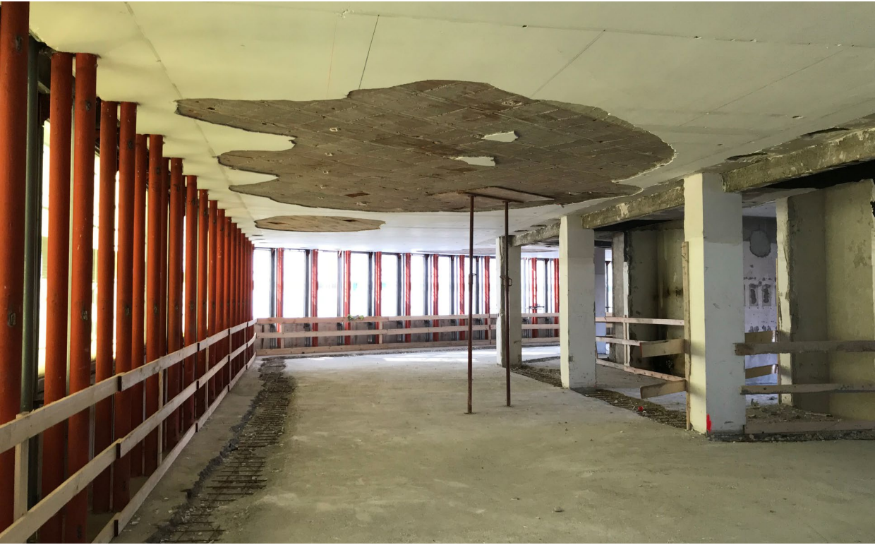
La facciata esistente era costituita da colonne metalliche circolari poste a un passo fitto di 1m. La sostituzione delle strutture esistenti con elementi in c.a., posti ad un passo pari a 4 volte quello delle attuali colonne, permette di guadagnare spazio interno ad ogni piano dell'edificio.
