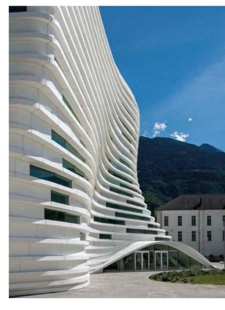
soni scatolari orizzontali in Betacryl, che formano la struttura portante delle partizioni vetrate e opache della facciata, fungendo anche da sistema di schermatura solare.
