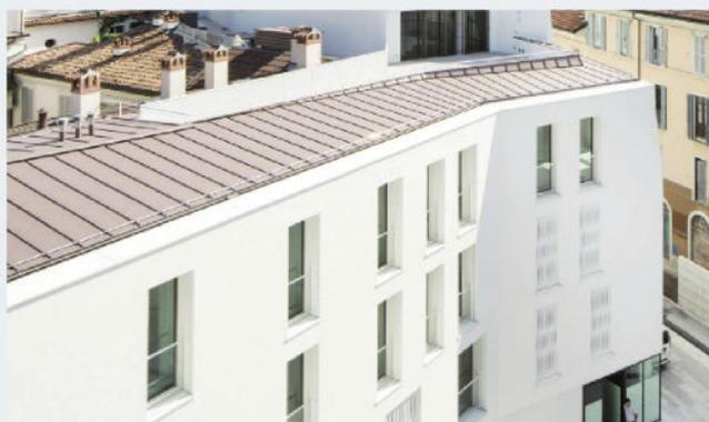
lastre uniche aggraffate e la stagnatura delle giunte dei canali incassati, anche vantaggi architettonici come l'inserimento nel contesto del centro storico di Milano con una tonalità di finitura Pigmento Rosso che ben si integra con le circostanti coperture tradizionali in laterizio.
