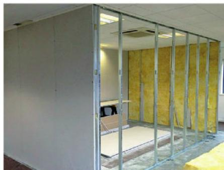
Sopra, esempio di posa di partizione interna con lastre di finitura in cartongesso.
