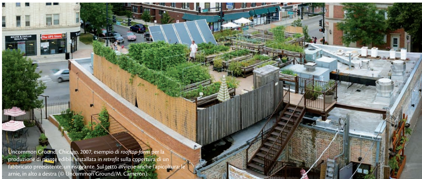
Giubbini Architekten, Raiffeisenbank, Chur, 2010, questa parete verde, utilizzando particolari tipi di piante ( Ficus Pumila e Philodendron scandens ) su substrati specifici (resine fenoliche), funge da elemento passivo per la climatizzazione dell'aria indoor . (© Art Aqua)
