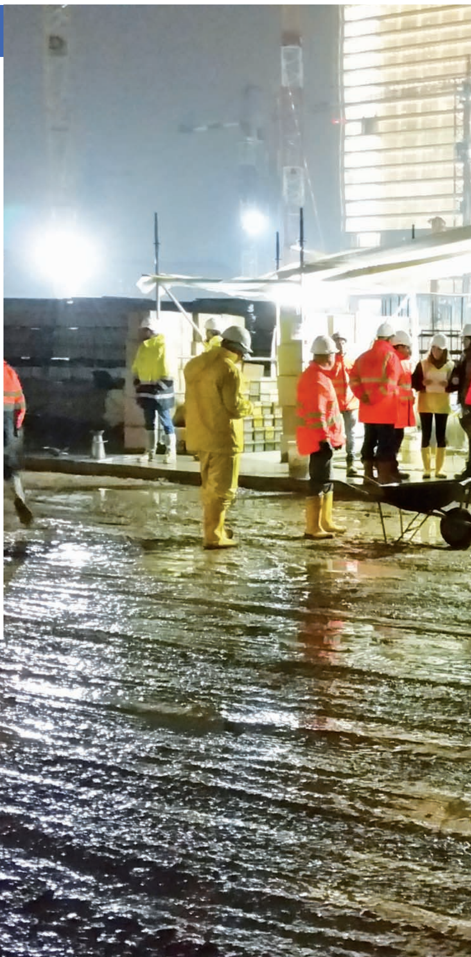
Getto in notturna per le fondazioni della Torre Hadid a Milano.
