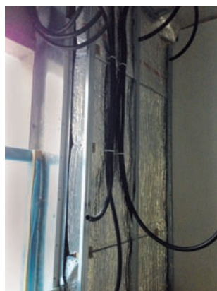
SISTEMA DI RIVESTIMENTO A PARETE VENTILATA CON ISOLANTE SOTTILE MULTISTRATO RIFLETTENTE.
