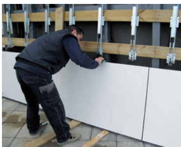
MURATURA CON RIVESTIMENTO A PARETE VENTILATA.
