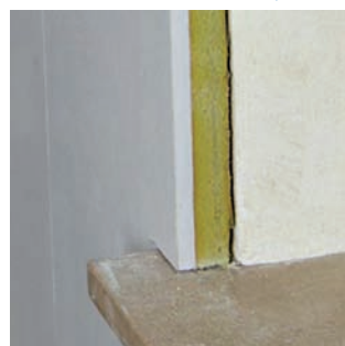
RECUPERO ENERGETICO DEGLI EDIFICI CON PLACCAGGIO INTERNO DELLE MURATURE.
