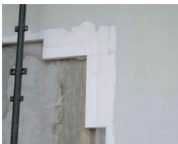
MURATURA CON ISOLAMENTO TERMICO A CAPPOTTO.
