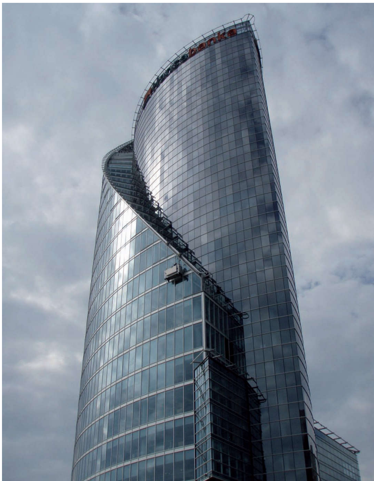
monorotaia rampante , sistema Roslift su binario RS137, altezza torre 120 m. Hansabank, Riga (Rostek Oy).
