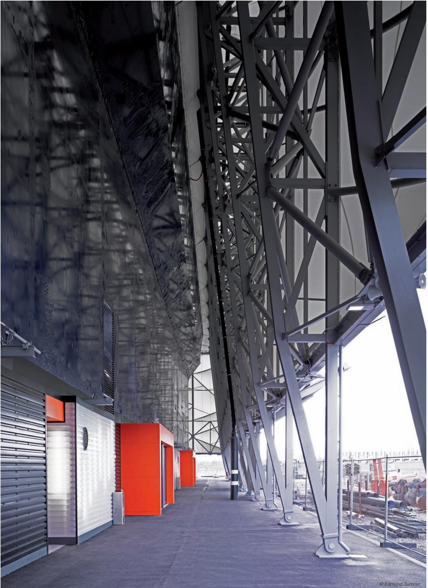
I teli in tensione a tutta altezza scandiscono campate di 6.00 mt e formano pieghe irregolari che intendono evocare l'impatto del lancio della palla. Il ritmo modulare dell'involucro è spezzato dalla tridimensionalità degli oggetti che adottano 6 tipi di configurazioni, ottenute dalle diverse inclinazioni e direzioni della sotto-struttura che consiste in archi in tubolare tondo, posti diagonalmente ad una distanza da 1.00 a 1.50 mt. dalla struttura primaria.
