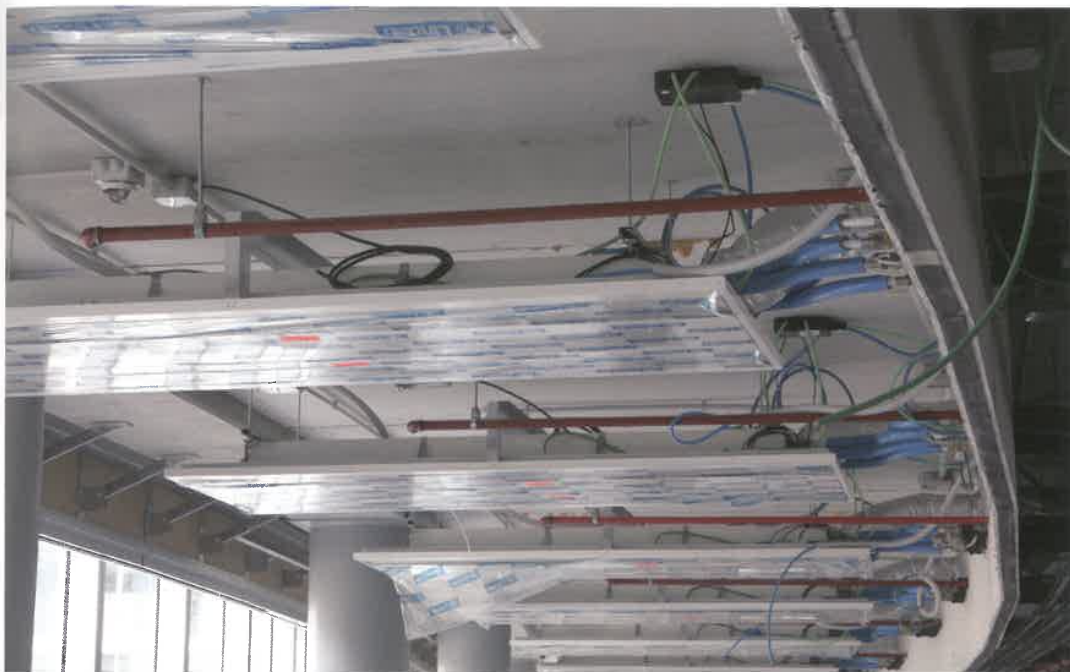
La complessità impiantistica del controsoffitto: in alto prima della chiusura con pannelli metallici.
