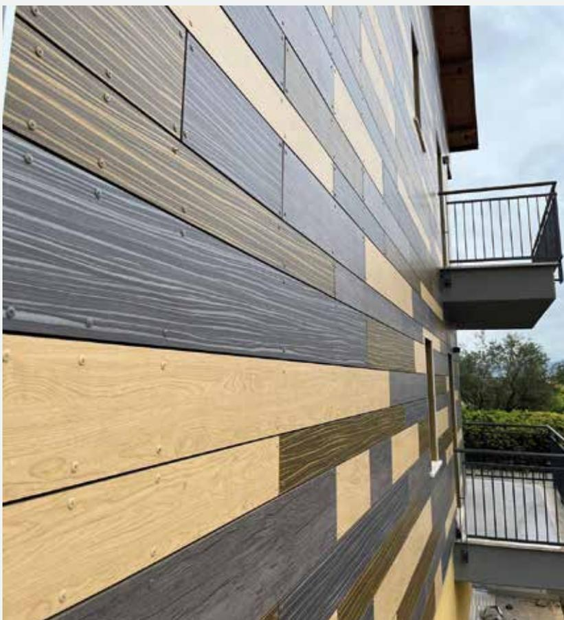
per garantire una maggior durabilità al sistema facciata, sono stati applicati i pannelli in lana di roccia precompressa Rockpanel Woods che, per mantenere una continuità visiva con la copertura, realizzata in legno lamellare, hanno riprodotto un interessante mix di finiture effetto legno, grazie al contrasto cromatico dei singoli pannelli di diverse tonalità.
