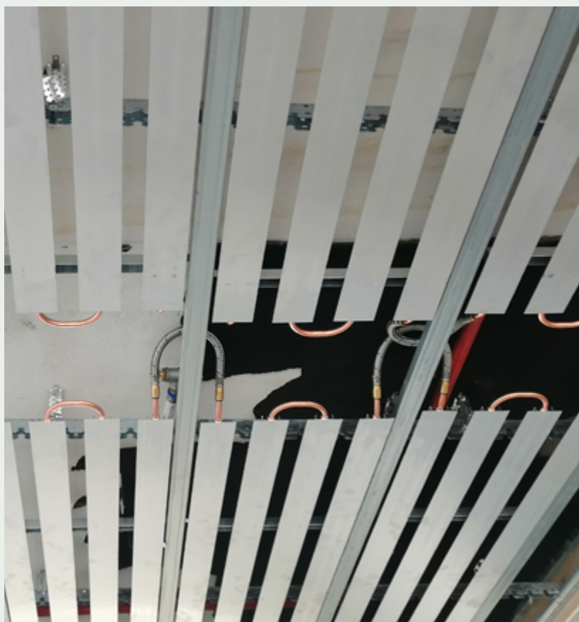
Plavorad GK in fase di installazione prima dell'applicazione della lastra in cartongesso
