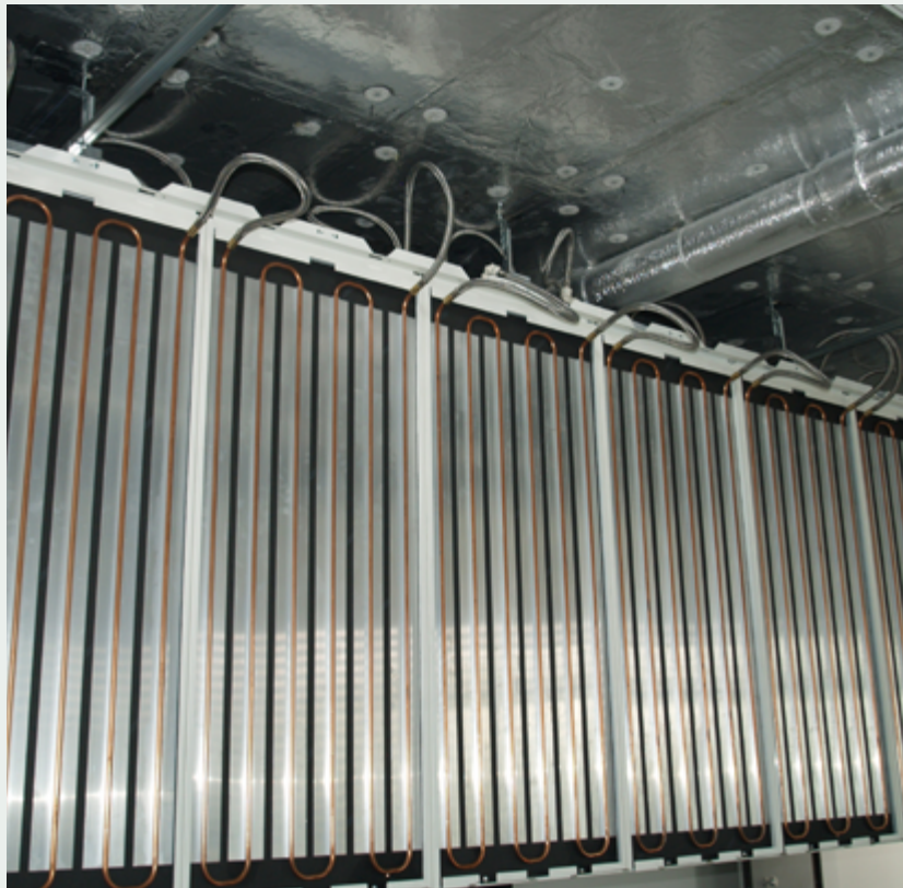
Particolare del Plaforad V aperto
