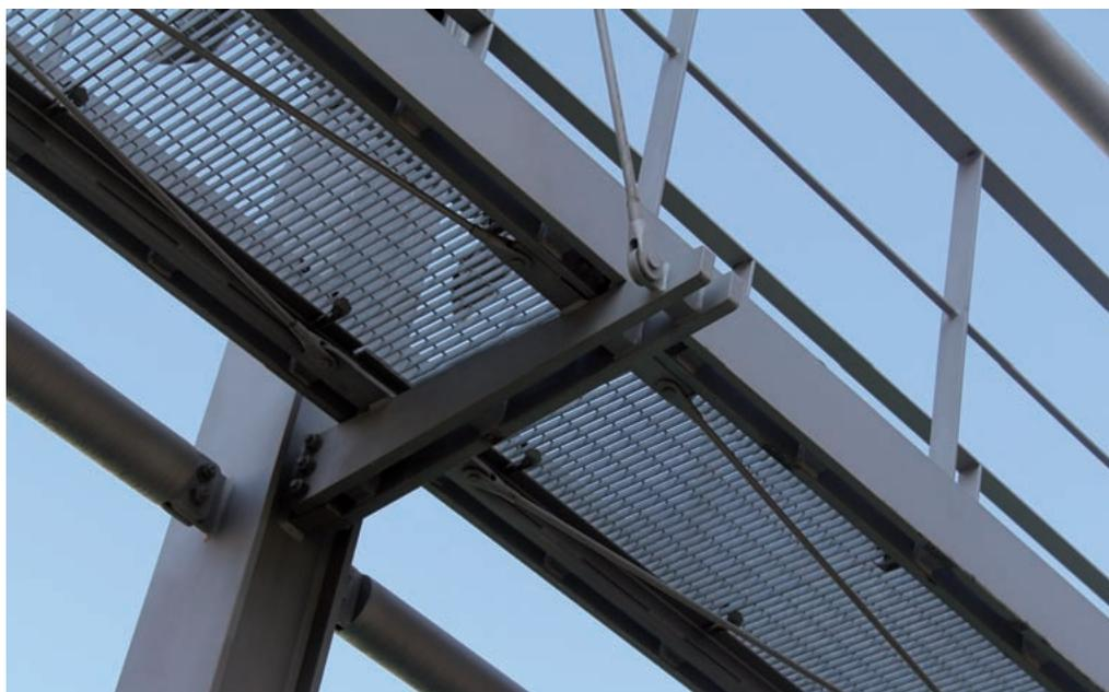
Un corridoio di servizio, sospeso in cima ai pilastri, agevola le operazioni di regolazione degli impianti, oltre che le attività di manutenzione.
