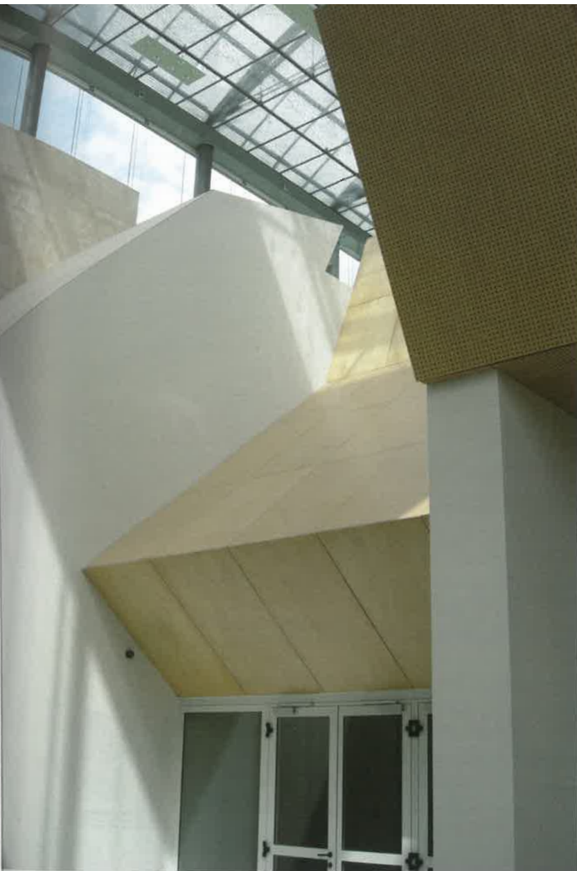
Particolare dell'attacco tra pilastro e trave nella serra (©Paolo Desideri - ABDR - SAC)
