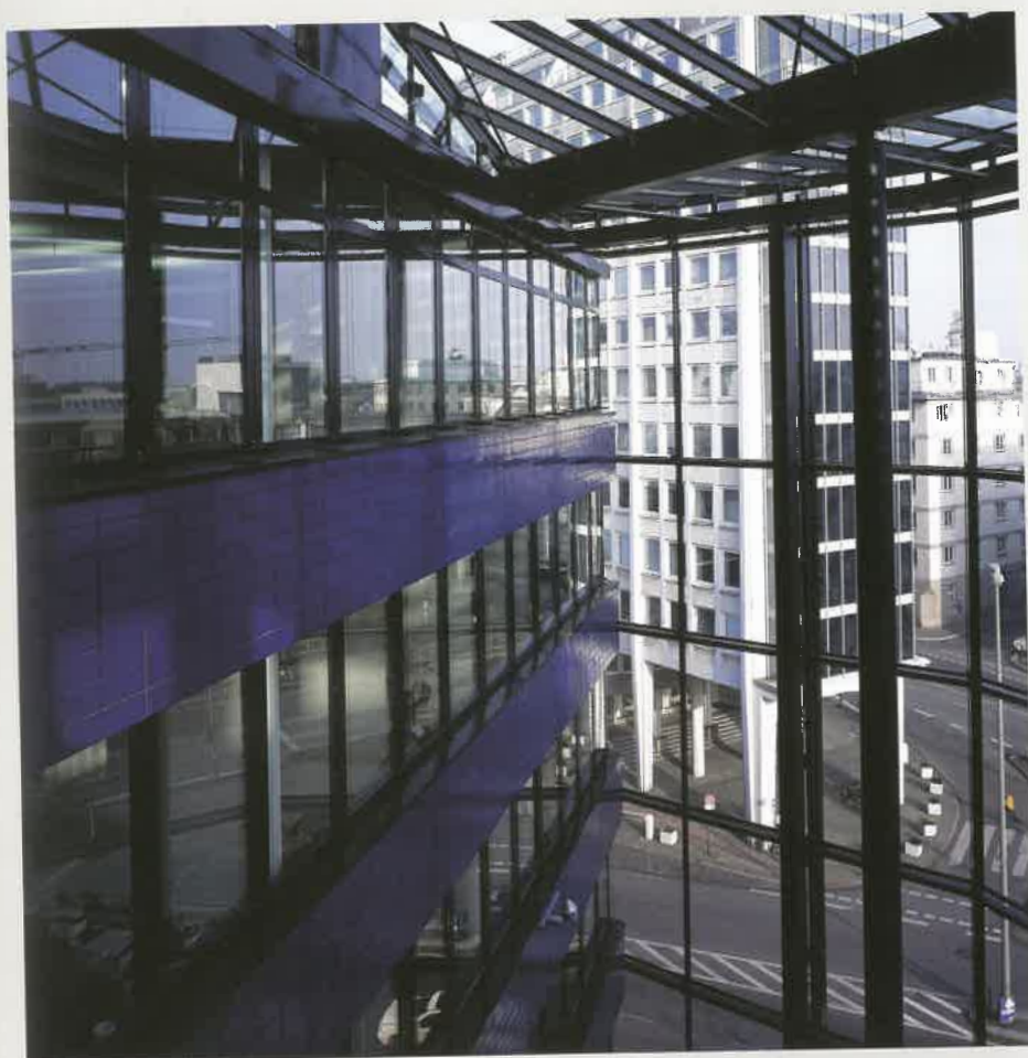
Vista interna dell'atrio in vetro tra i due edifici.
