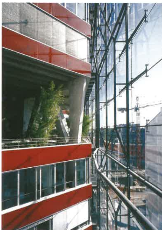
Facciata strutturale appesa con fissaggi puntuali realizzata dalla Frener & Reifer per il palazzo Doppel-xx di Amburgo (prog. Richter Teherani).
