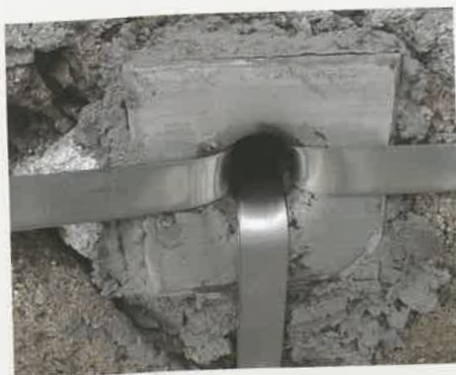
Applicazione delle cuciture su di un paramento murario ad opera incerta di scarsa qualità e nel quale le malte risultano compromesse ed inadeguate ad assolvere alcuna funzione legante.
