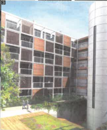
Volumetric: aggregazioni di unità tridimensionali secondo il lato corto
