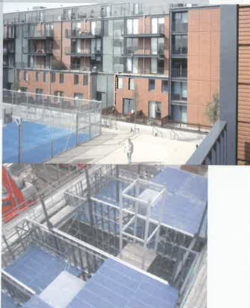
Feilden Clegg Bradley, Beaufort Court, Fulham, Londra, 2003. La soluzione strutturale ha previsto l'utilizzo integrato di moduli bagno tridimensionali, di pannelli verticali e orizzontali in CFS e di una struttura collaborante composta da profilati in acciaio a caldo (fonte: Feilden Clegg Bradley).
