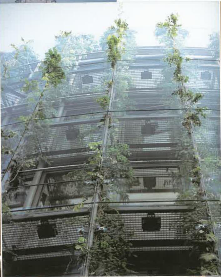
Sopra, l'integrazione della vegetazione in una doppia pelle. Nel recupero della facciata di questo edificio residenziale ad Amburgo l'involucro è stato trasformato in una doppia pelle trasparente. La struttura che supporta lo strato esterno permeabile all'aria e all'acqua diviene anche l'elemento di sostegno della vegetazione [Hill P., *Contemporary History of Garden Design, Europe-an Gardens between Art and Architecture*, Birkhauser, Basel, p. 125 e p. 126].
