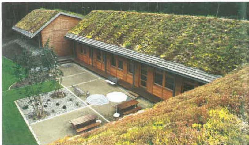
Per tetti piani senza riserva idrica o per tetti con bassa portata è un valido elemento di protezione, contro l'erosione del vento (Optigrun tipo "tetto inclinato").
