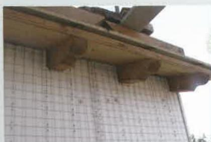
Il pannello cappotto Emmedue ristabilisce il giusto isolamento termico all'interno di edifici esistenti eliminando totalmente i ponti termici. Il sistema costruttivo si compone di pannelli modulari in polistirene e rete in acciaio zincato.
