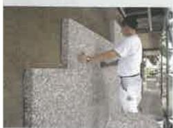
Capatect è un sistema per l'isolamento termico, applicabile sia in fase di costru-
