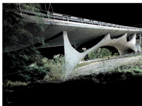
Nuvole di punti colorate di una campata del ponte Musmecì a Potenza e analisi delle geometrie e delle sezioni interne del ponte con software di modellazione (Asastudio).
