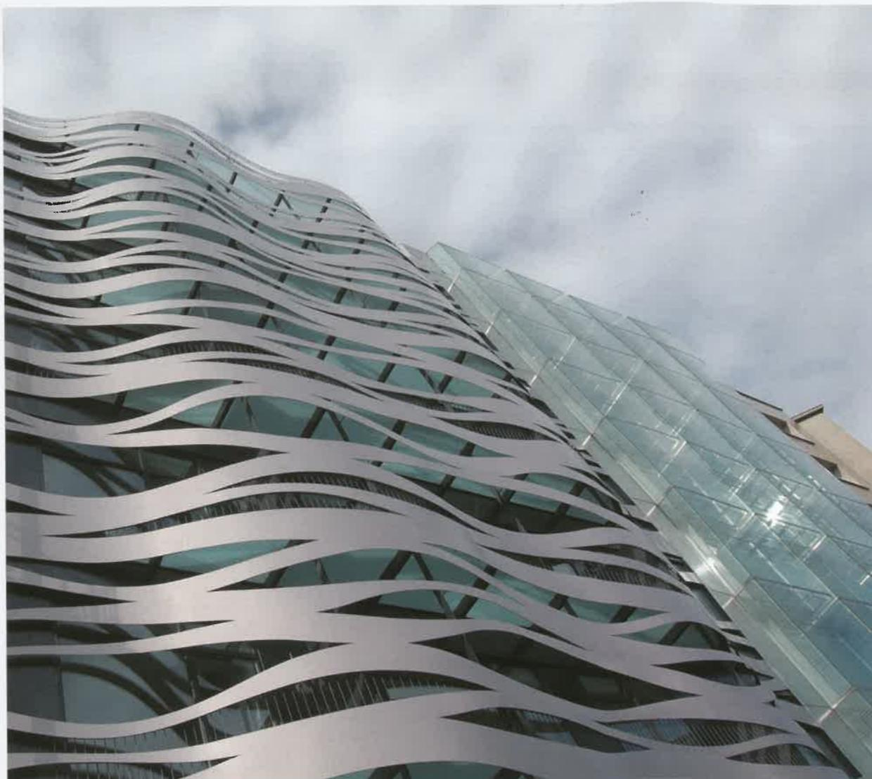
dimensioni (h.3.00 m x 7.50 m spess. 8 mm) sono state determinate anche dalle esigenze di trasporto e dai macchinari per il taglio laser. La nuova facciata, espressione dell'ultima sofisticata direzione di ricerca, è concepita come una pelle sottile che sembra quasi galleggiare davanti all'edificio: un effetto determinato anche dallo spazio aggiunto per alloggiare i balconi ed inserire la struttura portante del nuovo rivestimento.
