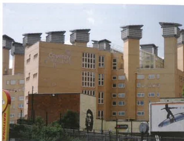
Sopra: Coventry University, Londra, con le torri del vento. A sinistra: la Russia Tower, progettata da Norman Foster per la città di Mosca, sarà il più alto edificio del mondo con ventilazione totalmente naturale.
