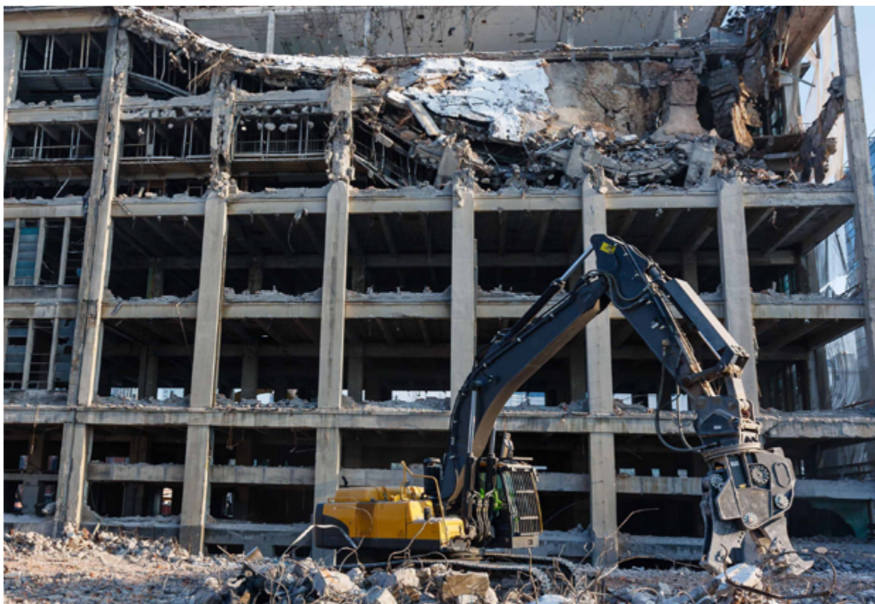
Demolizione tramite escavatore munito di cesoie. (Fonte: thebalancesmb.com)
