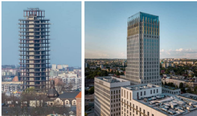
Esempio di scheletro edilizio di edificio a torre prima e dopo l'intervento di recupero, completato nel 2020 (Cracovia, Polonia). La costruzione dell'edificio iniziò nel 1975, ma fu interrotta definitivamente nel 1981 a causa di vincoli economici e disordini politici. (Fonte: https://krakow.naszemiasto.pl )
