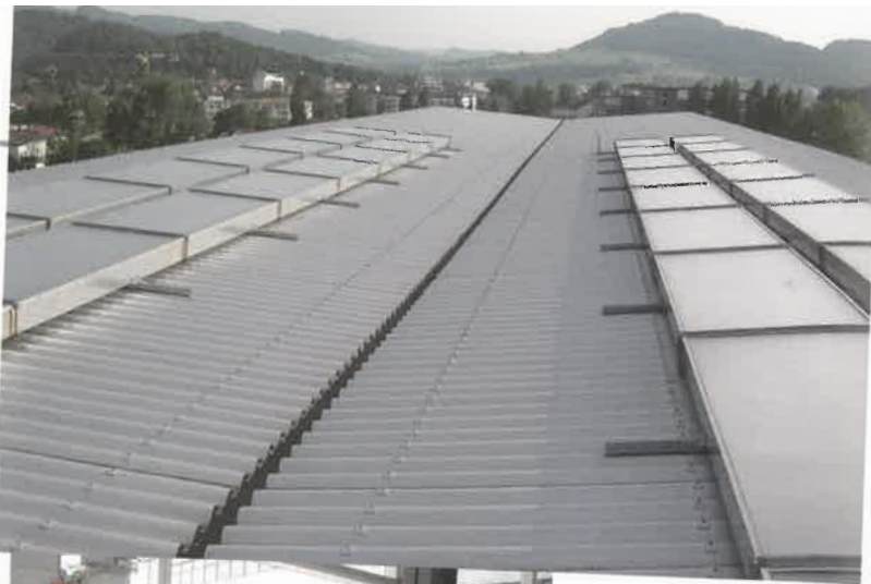
Sopra, IHK - Camera di Commercio di Friburgo (Germania). Collettori solari ad aria che alimentano un sistema a desiccant cooling.
