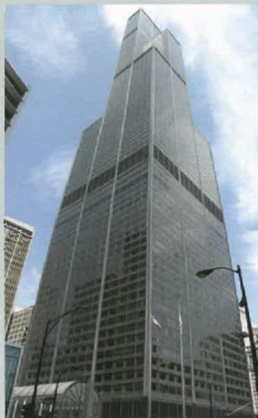
La Sears Tower di Chicago, l'edificio più alto dal 1974 al 1998, ha rappresentato un'importante innovazione strutturale: il grattacielo progettato da SOM e Fazlur Khan utilizza un sistema strutturale a "fascio di tubi" che ha permesso di superare le inefficienze dei sistemi a telaio rigido (D.T.)
