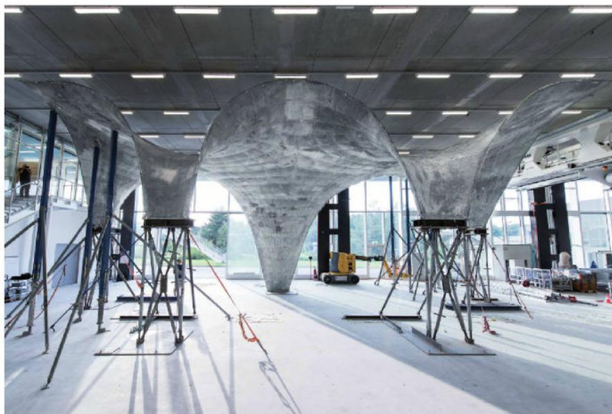
finding) e Octopus (per l'ottimizzazione multi-obiettivo). Alta 7,5 m complessivi e con una superficie di 160 mq che copre un'area piana di 120 mq, tale superficie anticlastica è data da una parabola gaussiana a curvatura negativa, il cui calcestruzzo registra uno spessore medio di soli 5 cm.
