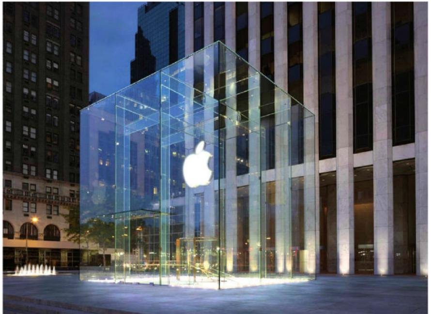
New Cube for 5th Avenue Apple Store, New York, ricostruito nel 2011. Si tratta di uno dei primi esempi di struttura di vetro con lastre laminate inflesse fuori del loro piano medio, destinate a orizzontamenti calpestabili e pareti di facciate continue. Le nervature orizzontali e verticali anch'esse laminate ma inflesse nel loro piano medio, sono spesso utilizzate per sostenere e irrigidire le precedenti superfici (fotografia courtesy Eckersley O' Callaghan engineers)
