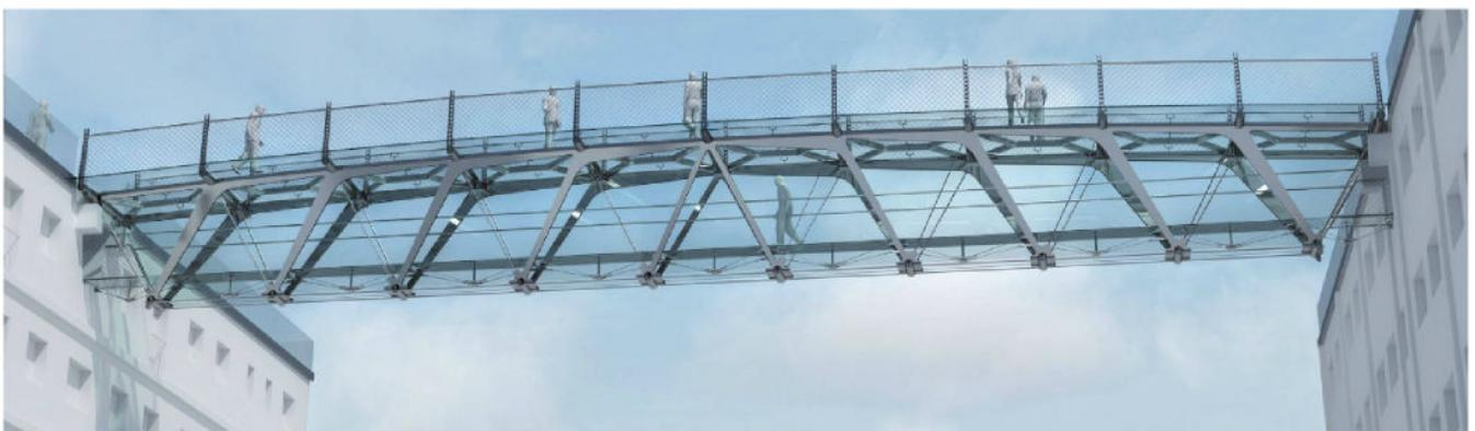
Progetto di una passerella pedonale di luce 30 m realizzata mediante il sistema TVT Gamma "Monster".
