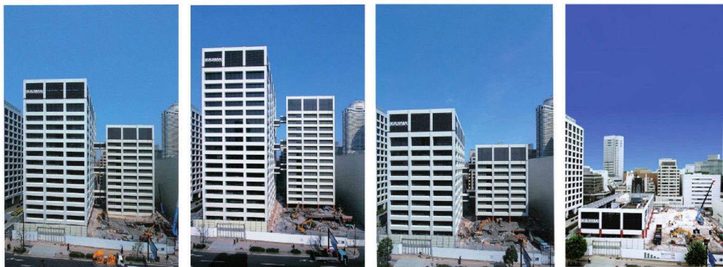
Sistema "Cut and Take Down" di Kajima applicato al quartier generale (per cortesia Kajima)
