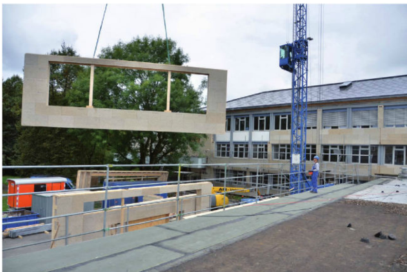
Movimentazione componenti di facciata
