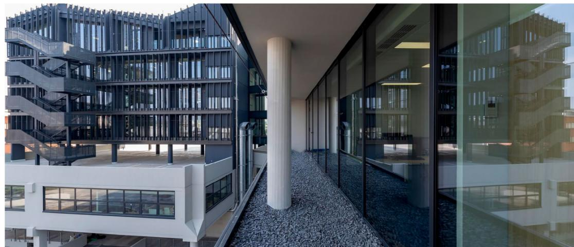
nuovo volume in copertura del corpo Sud che volutamente è stato arretrato rispetto al filo della rispettiva facciata e traslato verso il corpo Nord: le forme del nuovo involucro di vetro e acciaio, con i piani inclinati in copertura e la pelle di facciata costituita da lamelle verticali in lamiera forata color brunito, richiamano la copertura esistente dell'originario Auditorium.
