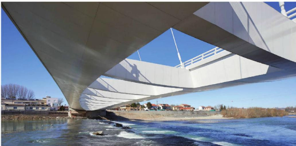
zio vuoto centrale a forma di mandorla e interconnesse attraverso travi e cavi d'acciaio che configurano il modello strutturale.
