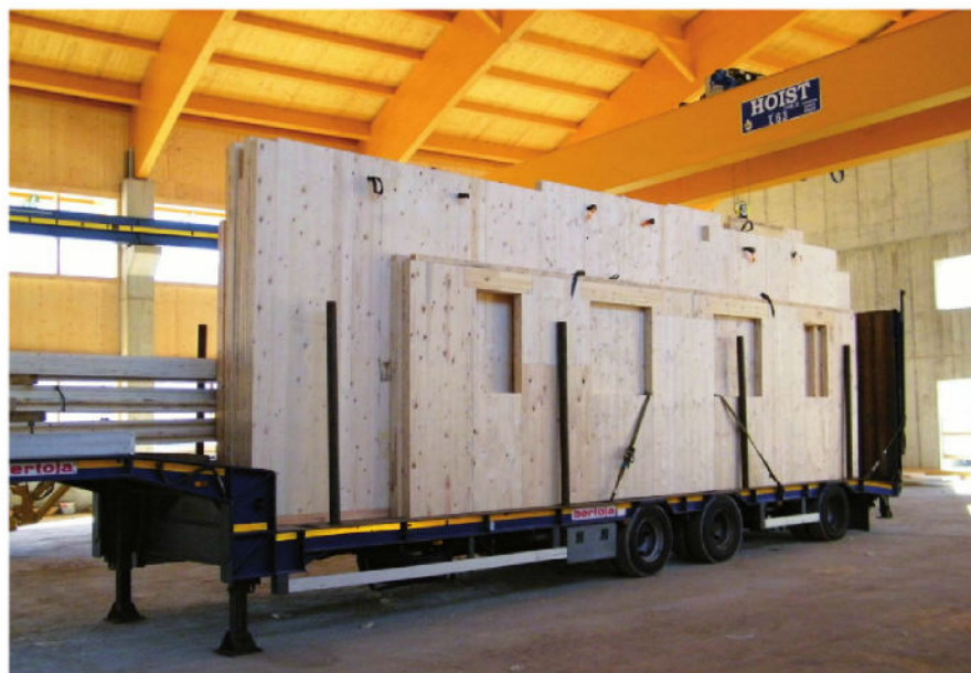
Trasporto di elementi in CLT.
