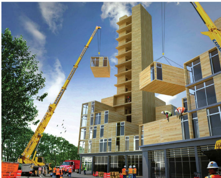
Esempio di posa di celle prefabbricate in legno. Fonte: cargocollective.com
