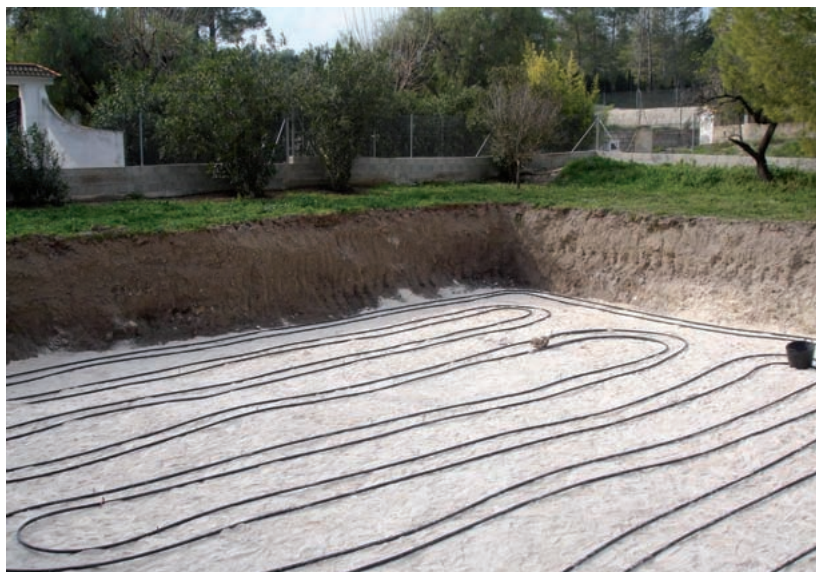
Esempio di scambiatore geotermico a bassa profondità.
