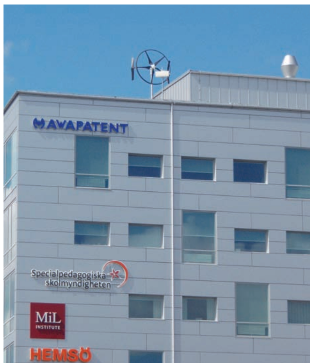
Esempio di generatore eolico ad asse orizzontale integrato in copertura.
