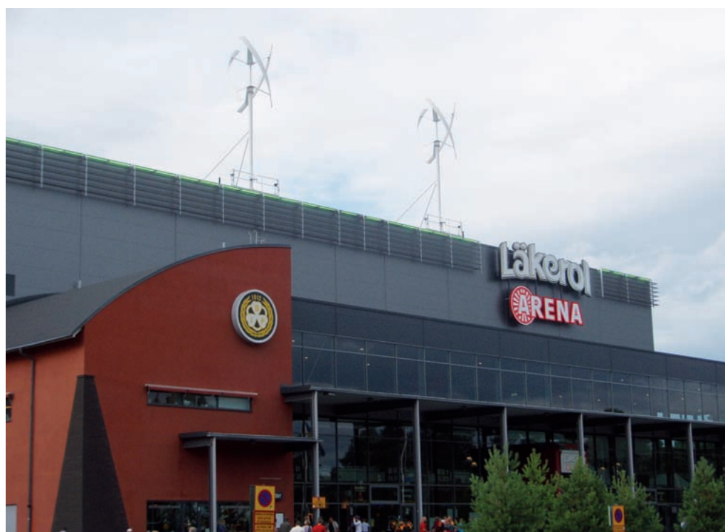
Esempio di generatori eolici ad asse verticale posti in copertura. Si notano le strutture di supporto e controvento.
