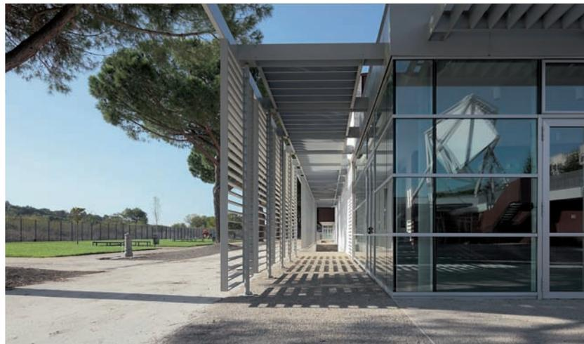
IL CONTROLLO DELLA RADIAZIONE SOLARE HA COMPORTATO IL DISEGNO DI *BRISE-SOLEIL* ORIZZONTALI FISSI CHE, GRAZIE ALLA DIVERSA ANGOLAZIONE, PROTEGGONO LE FACCIATE VETRATE ESPOSTE AD EST/SUD/OVEST DALL'IRRAGGIAMENTO SOLARE IN ESTATE, CONSENTENDO L'INGRESSO DELLA LUCE NATURALE IN INVERNO.
