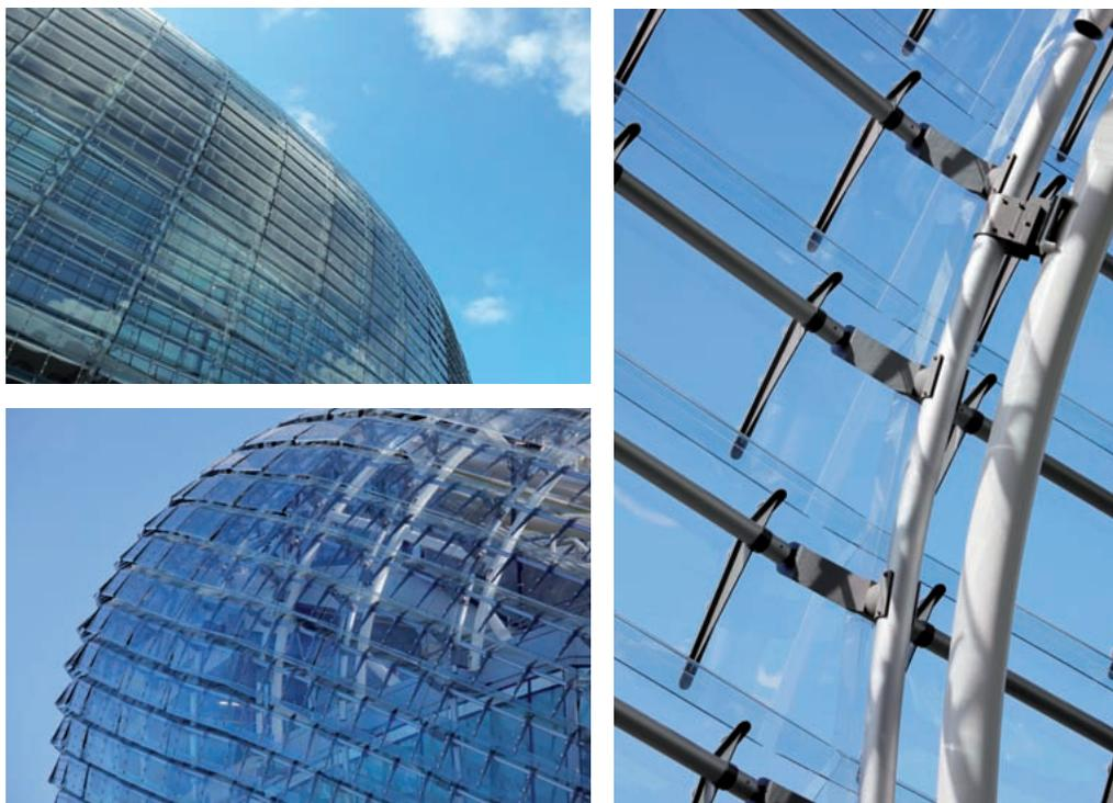
Uno stadio virtuoso e sostenibile: l'involucro assorbe i raggi UV, l'opacità graduata controlla l'irraggiamento solare e la configurazione variabile delle lastre lo rende permeabile all'aria
