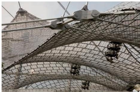
La copertura trasparente, composta da pannelli rigidi in materiale acrilico, è collegata alla rete di cavi in acciaio della tensostruttura attraverso piedistalli in neoprene che permettono di compensarne i movimenti.
