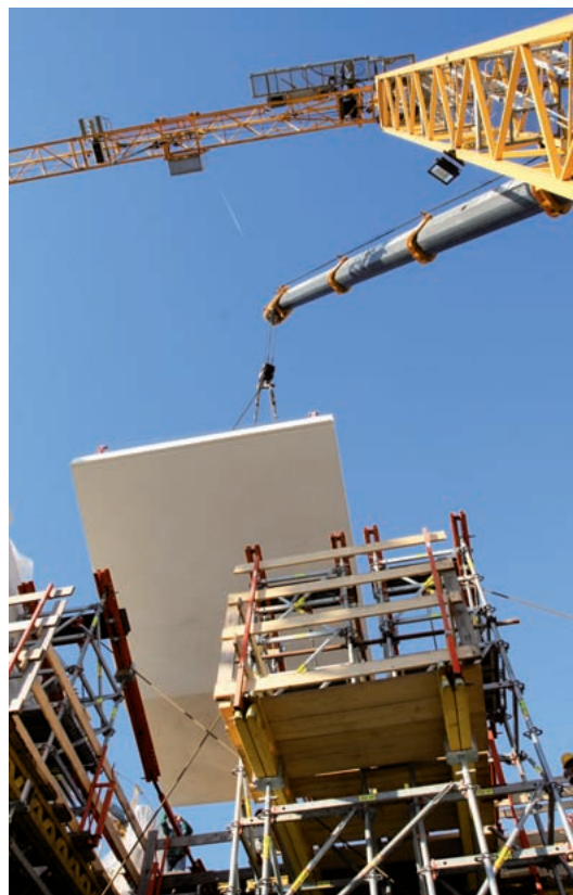
Posizionamento dei tegoli prefabbricati
