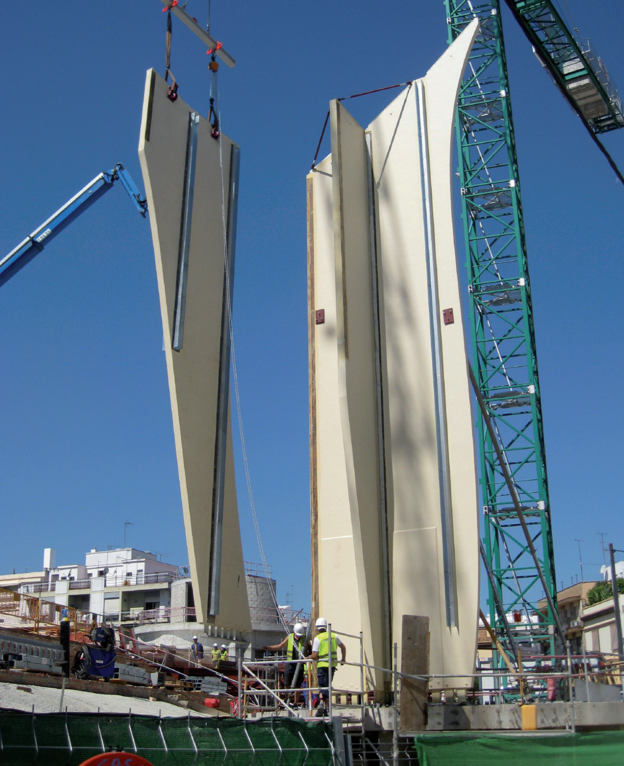
A sinistra: il montaggio dei pannelli di rivestimento delle strutture portanti. In basso: la struttura portante in cls in costruzione.
